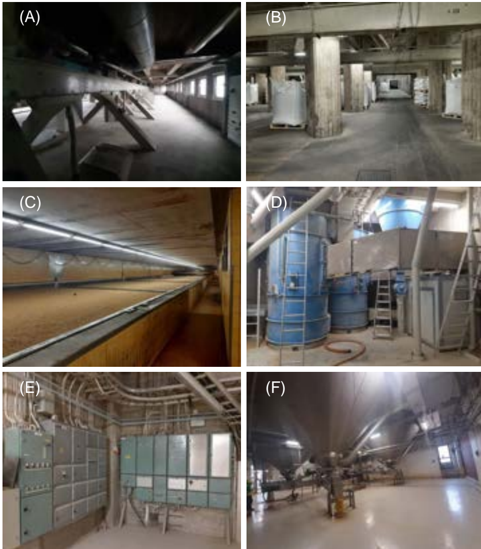
Kuva 3. (A,B) Tukirakenteita, (C) mallastamo, (D) koneita, (E) sähkökeskus, (F) siiloja.
